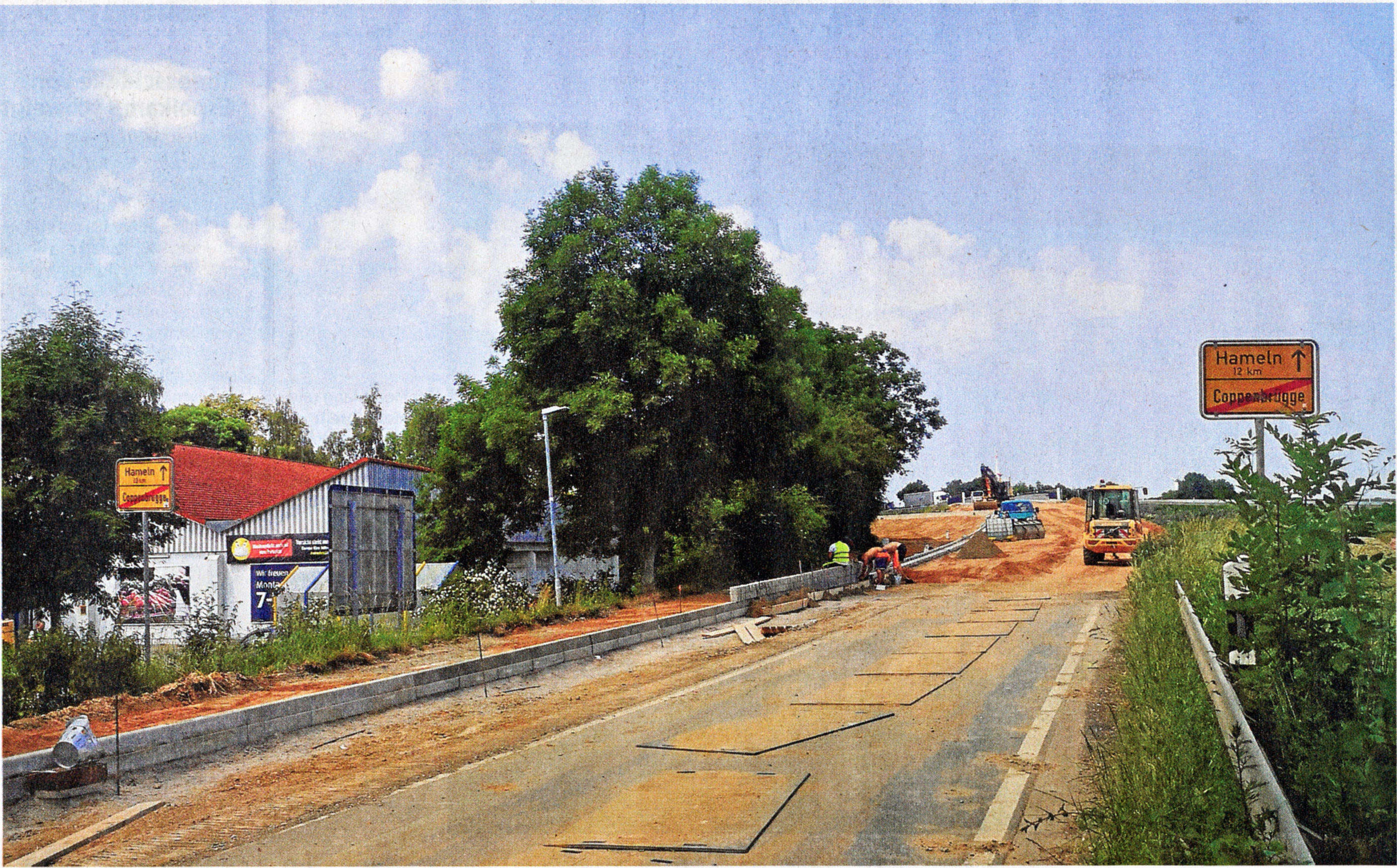
Die gefährliche Straßenführung der alten B1 am westlichen Ortseingang von Coppenbrügge ist komplett weggefräst und die Arbeit an der neuen Trassenführung läuft auf Hochtouren. FOTO: IST
